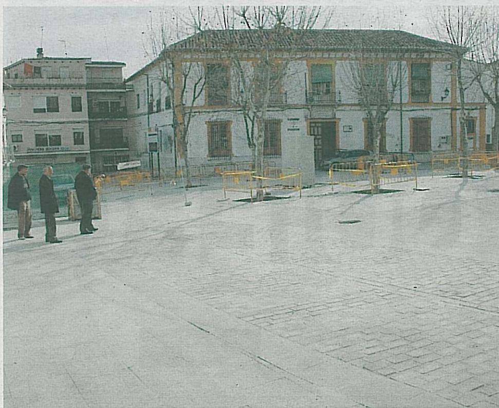
Obras en el Barrio de Santiago.
