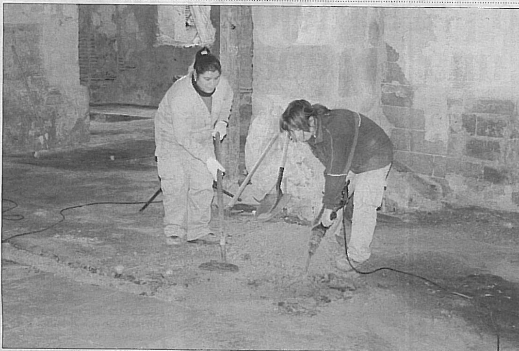
Operarias municipales trabajando en el convento de San Jerónimo.
