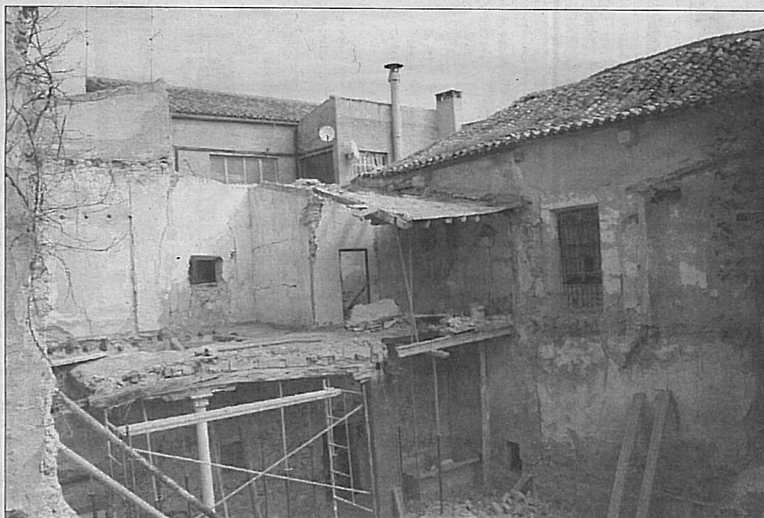
Apecto que presentaba el edificio de la Alhóndiga hace dos años, antes de que iniciara sus trabajos en él el Taller de Empleo "La Alhóndiga".
